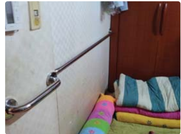
⬆ 현관 및 침실 손잡이 설치 예
