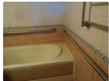
⬆ 화장실 및 욕실 손잡이 설치 예
