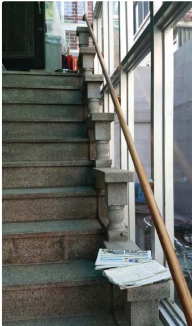
⬆ 실외 계단에 안전손잡이 설치 예
