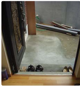
④ 출입구에 경사로를 설치한 예 (이동형으로 탈부착 가능)
