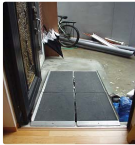
④ 출입구에 경사로를 설치한 예 (이동형으로 탈부착 가능)
